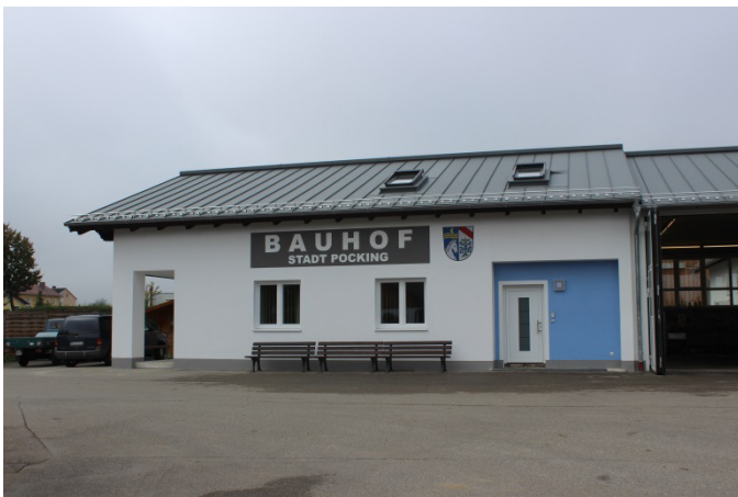
Bauhofgebäude mit „neuer“ Fassadengestaltung
