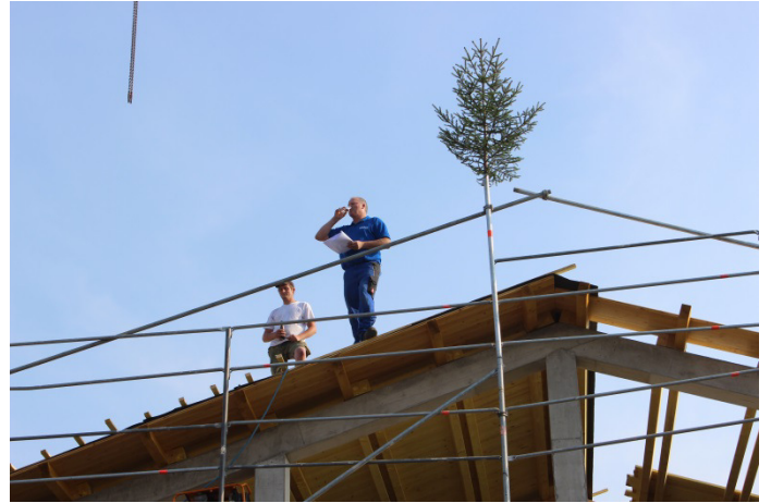
Richtspruch Firma Deisböck Zimmerei
