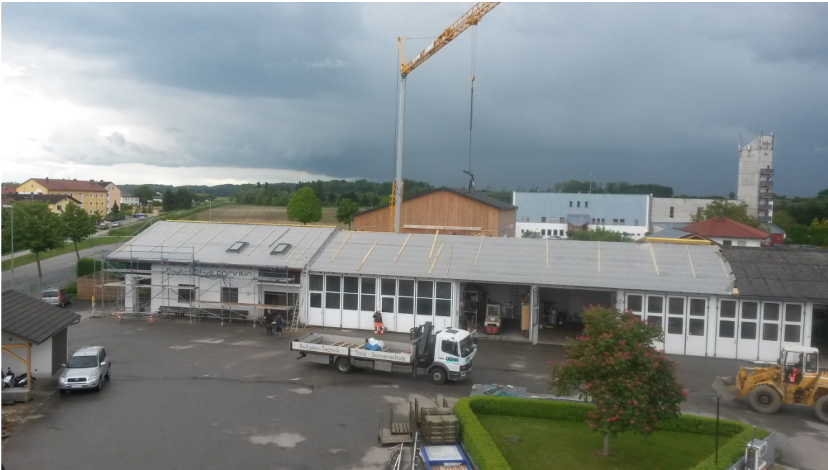
Sanierung Bauhof (Dach, Fassade, Fenster, 2 Tore)
