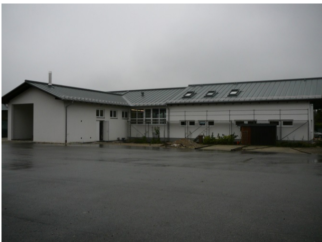
Anbau Heizzentrale für Hackschnitzelheizung
